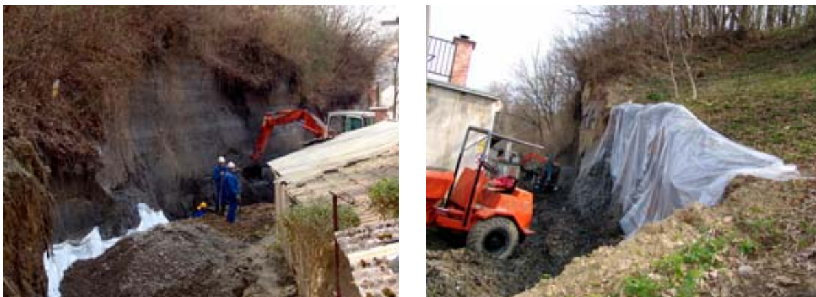
Slika 20. Sanacija klizišta Gudura (preuzeto s www.zagreb.hr )
