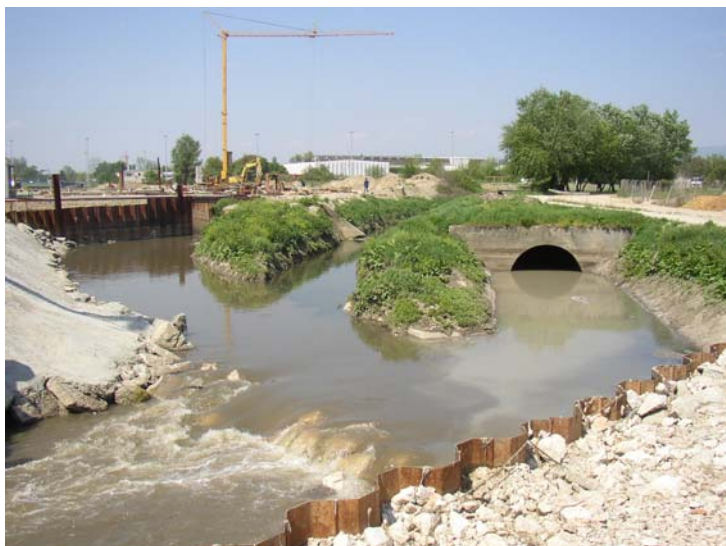
Slika 13. Radovi na zatvaranju Glavnoga odvodnog kanala (GOK)
