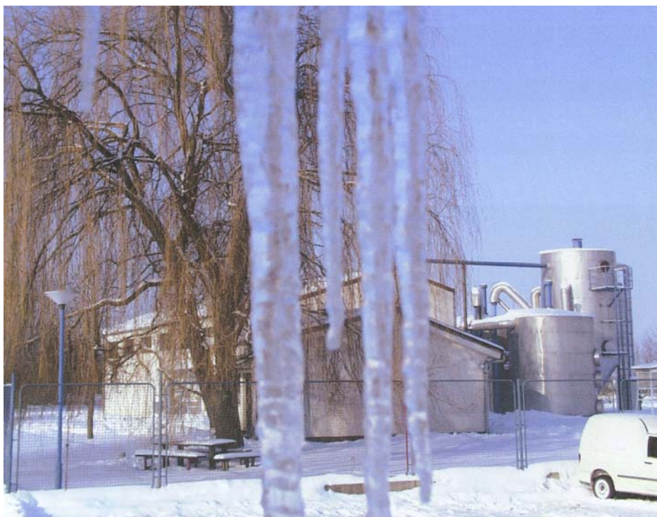
Slika br. 8. Postrojenje za preradu pitke vode u Virovitici
