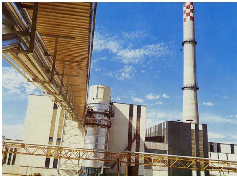
Slika br. 13. Dimnjak iz energane tvornice šećera u Virovitici
