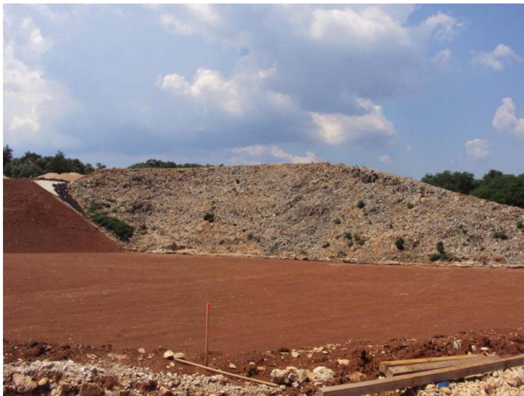
Datum: 29. 4. 2009. – Izgrađeni temeljni brtveni sustav
