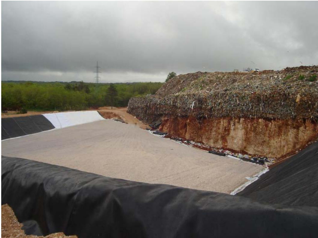
Datum: 29. 4. 2009. – Izgrađeni temeljni brtveni sustav
